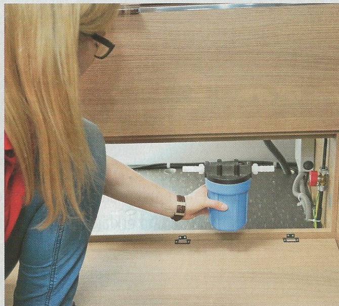
Eingebaut: Bevor ein Filtersystem im Fahrzeug integriert wird, gilt es, den verfügbaren Platz am vorgesehenen Montageort zu inspizieren.
